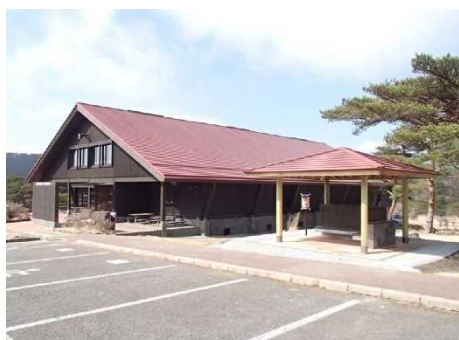
写真：火山災害に備えて、建物躯体への大きな被害を防止するためのアラミド繊維による屋根の二重化、噴石被害を防ぐ防護柵や外付けブラインドの設置等補強改修工事を行ったビジターセンターの事例(写真は報道発表資料より引用)
