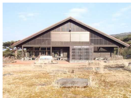
写真：火山災害に備えて、建物躯体への大きな被害を防止するためのアラミド繊維による屋根の二重化、噴石被害を防ぐ防護柵や外付けブラインドの設置等補強改修工事を行ったビジターセンターの事例(写真は報道発表資料より引用)
