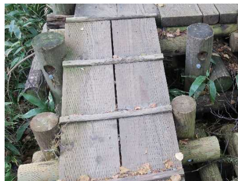
写真：インサイジング加工（木材保存剤を深く、均一に浸透させる加工）し加圧注入処理を施した木材を使用して部材交換している木道
