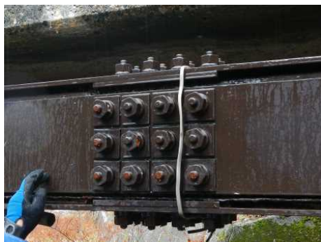
写真：温泉による酸性ガスで金属部の劣化進捗が速いため、酸性ガスの影響を受けない場所よりも修繕（塗装）の頻度を上げて対策している鋼橋
