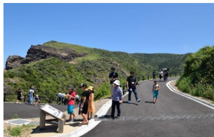
バリアフリー園路整備（隠岐西ノ島）
