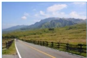
草原景観を配慮した安全柵
