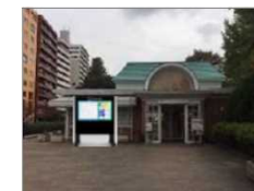
デジタルサイネージの設置
