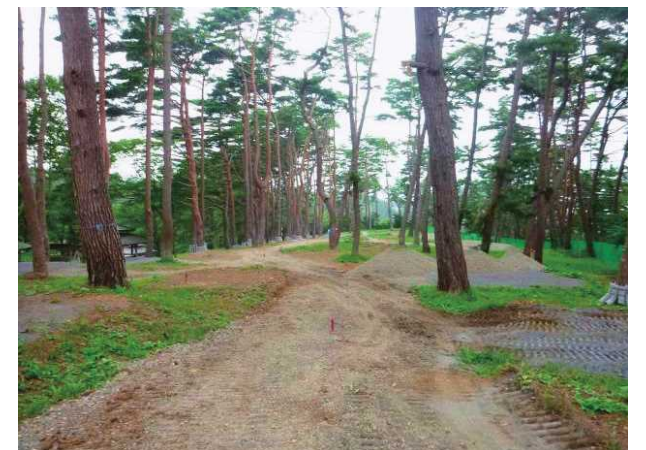
碓氷海岸野営場のオートサイトの再整備（工事中）
