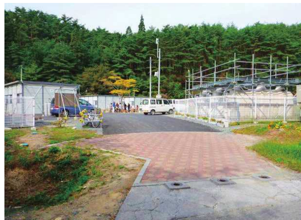
気仙沼大島の仮設住宅
