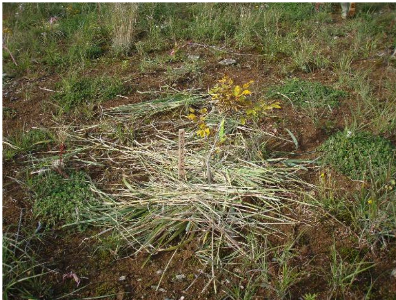
図 4－3－7 現地で刈り取りしたススキによるマルチング
