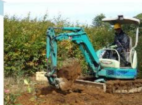
② 土壌ブロック掘採り
