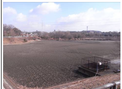
池干し中の雨池
