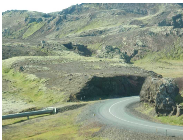
景観の重視されるエリアで配管の地下埋設を行った事例（アイスランド）
