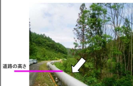
○上の岱地熱発電所
