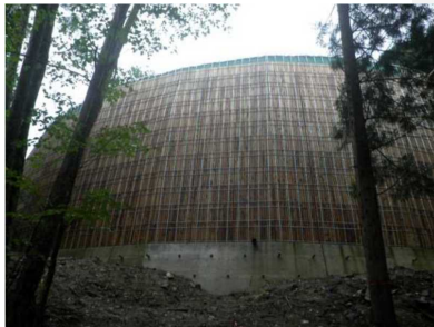
間伐材を用いた擁壁の修景
