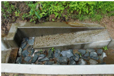
両生類の移動に配慮した這い上がりスロープ付きの側溝、産卵場として環境整備した集水樹
