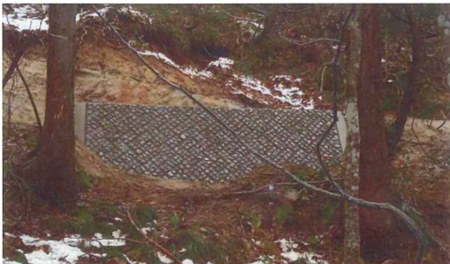
ナチュロックを用いた擁壁の修景
