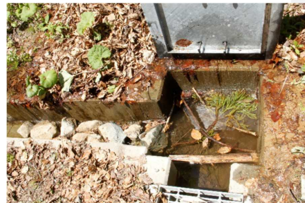
両生類の移動に配慮した這い上がりスロープ付きの側溝、産卵場として環境整備した集水樹
