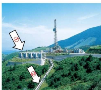
○八丁原発電所2号機 坑井基地
