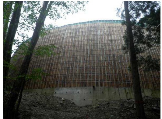
間伐材を用いた擁壁の修景
