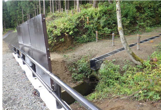
コウモリ類が生息する隧道への遮光板設置
