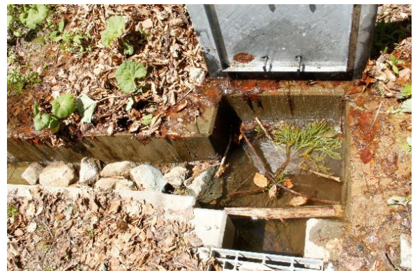
両生類の移動に配慮した這い上がりスロープ付きの側溝、産卵場として環境整備した集水枡
