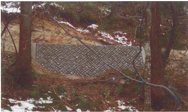
ナチュロックを用いた擁壁の修景
