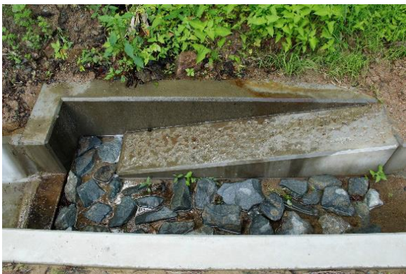
両生類の移動に配慮した這い上がりスロープ付きの側溝、産卵場として環境整備した集水枡
