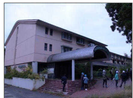
湖畔方向の景観（廃屋撤去前）
