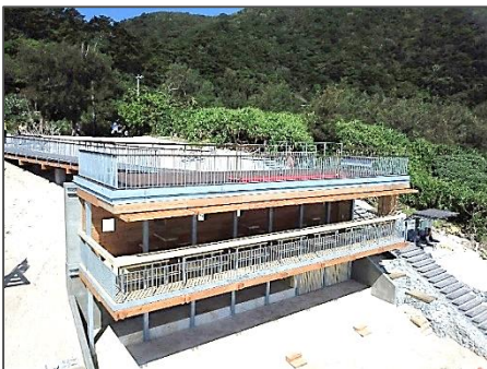
ニシバマテラスの全景写真
