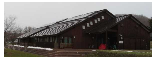
ビジターセンターへの太陽光導入（支笏洞爺）
