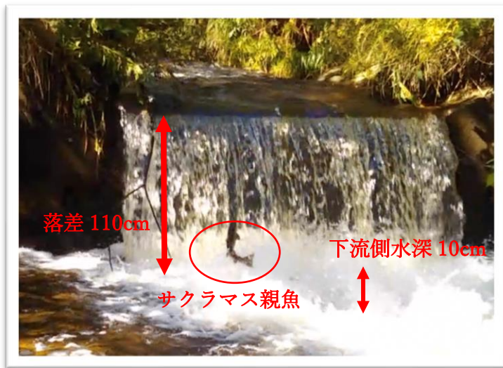
写真 4. 落差工下流でジャンプするサクラマス
