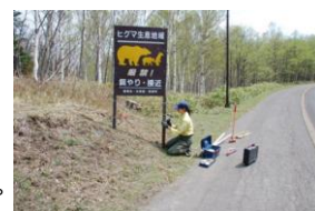
車道脇へのヒグマ注意看板設置作業
