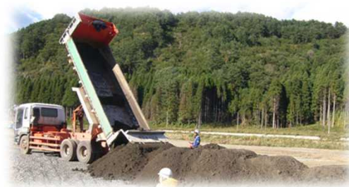
海岸防災林の被災状況及び復旧事業予定箇所への津波堆積物の搬入状況(摂待地区)
