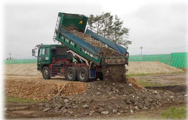
再生資材(コンクリートくず)の初搬入(7月3日)
