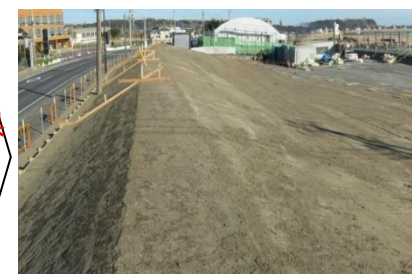
◎無害化された津波堆積物(土砂)を 海岸防災林の盛土材として活用。
