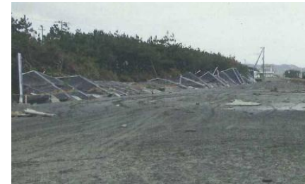
◎被災した海岸防災林
