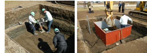
試験施工の様子
