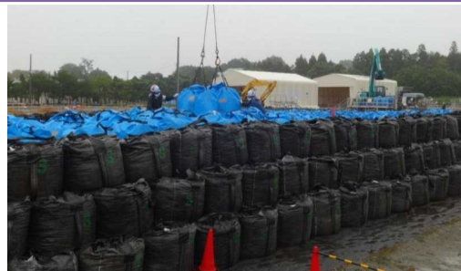
保管場への定置作業
