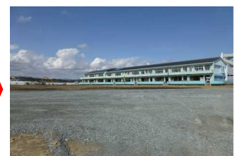
撤去後(平成27年3月)
