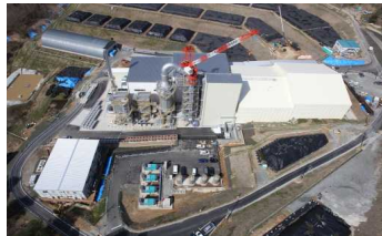
葛尾村の仮設焼却施設 (平成27年4月)
