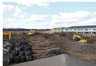
撤去前(平成26年1月)
