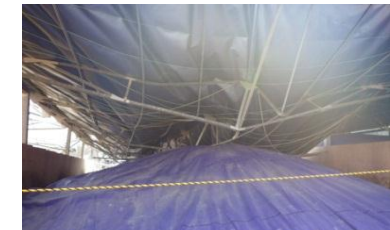
【大雪によりテントの屋根が破損した様子】
