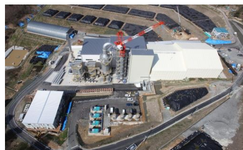
葛尾村の仮設焼却施設 (平成27年4月)
