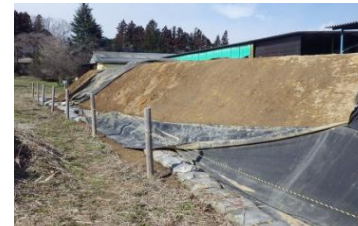
【強風により遮水シートがまくれ上がった様子】
