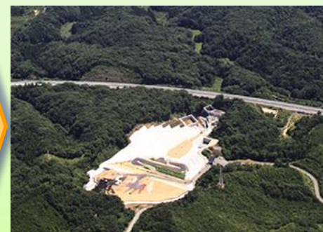
特定廃棄物埋立処分施設 (旧フクシマエコテッククリーンセンター)
