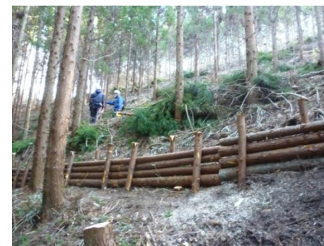
放射性物質を含む枝葉や土壌が森林外に流出しないよう、間伐木の枝葉を林内で集積(写真左)するとともに、木柵工を設置(写真右) (いずれも福島県有林(鮫川村))
