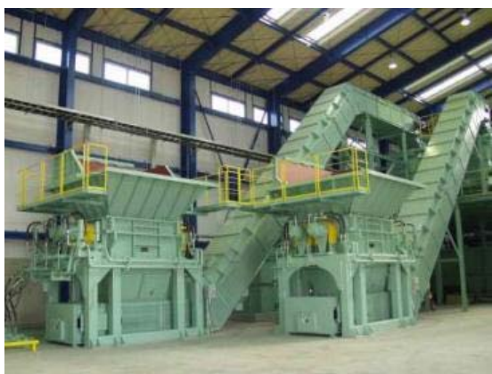
図 4-3 破砕機の屋内設置（例）
