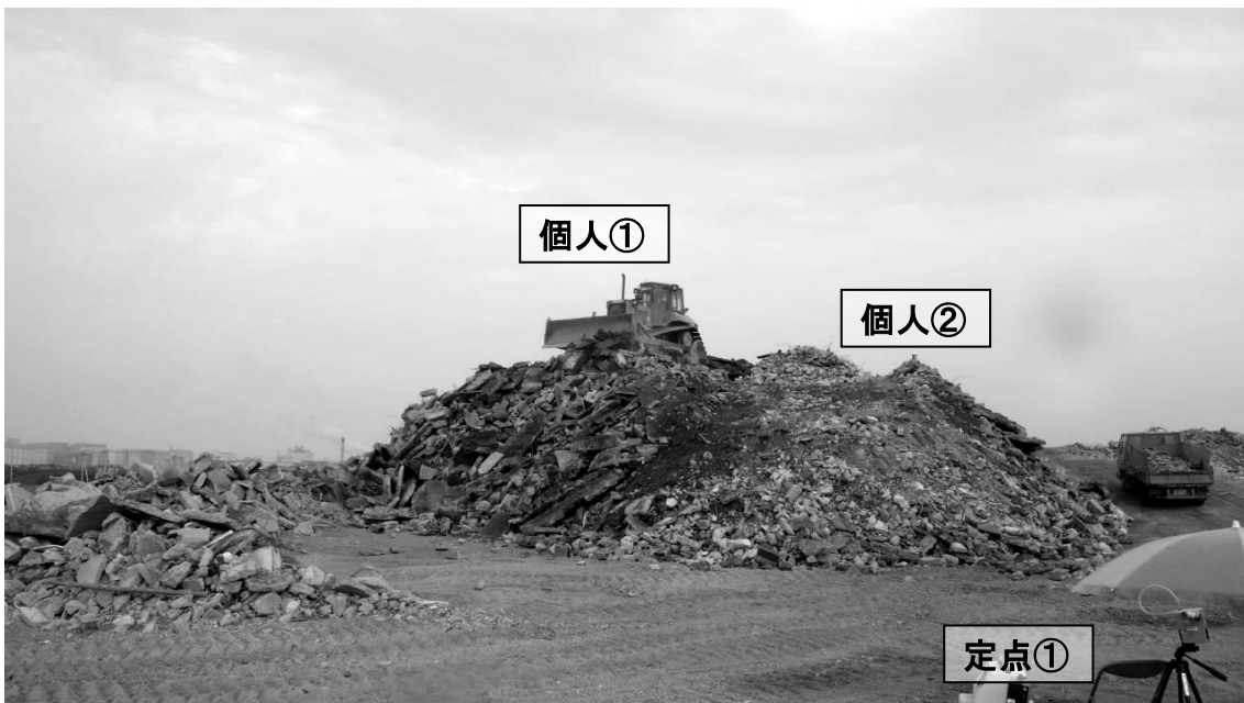
図 5 重機による作業の様子(がれき集積場 B・南側から)
