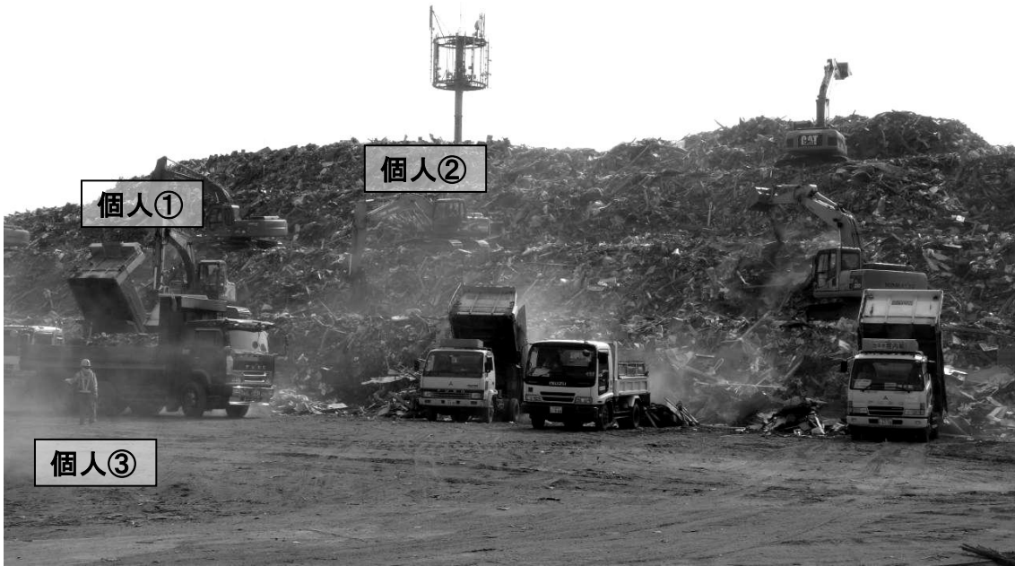
図 4 重機による作業の様子(がれき集積場 A・東側から)
