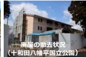
廃屋の撤去状況(十和田八幡平国立公園) 廃屋撤去、景観改善、多言語解説の整備等
