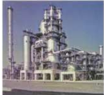
<石油精製所を活用したリサイクル設備>
