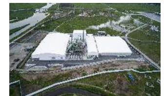
浪江町 仮設焼却施設
