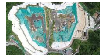
特定廃棄物埋立処分場
