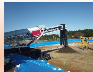
中間貯蔵施設 土壌貯蔵施設
