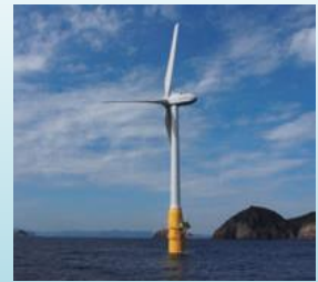
洋上風力発電施設 (H28環境白書より)
