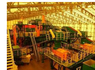
除去土壌等の受入・分別施設
