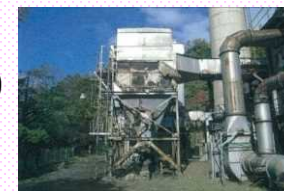
老朽化した廃棄物処理施設の更新
