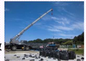
除去土壌等の搬出の様子
