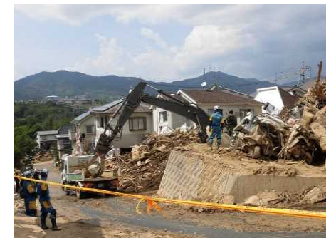
②損壊した家屋等の解体、がれきの収集・運搬及び処分
