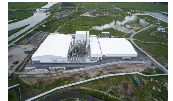
浪江町 仮設焼却施設
