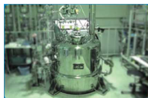
<バイオマスプラスチック製造設備>
