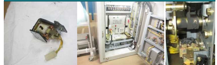
特別高圧受変電設備の老朽化状況
