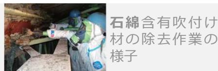
石綿含有吹付け材の除去作業の様子
