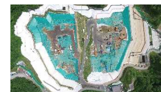
特定廃棄物埋立処分場
