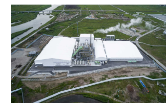
浪江町 仮設焼却施設
