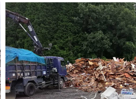
②損壊した家屋等の解体、がれきの収集・運搬及び処分
