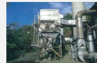
老朽化した廃棄物処理施設の更新
