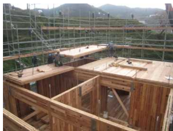
CLTを用いた施工例
