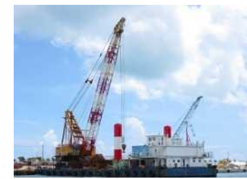
施工クレーン台船
