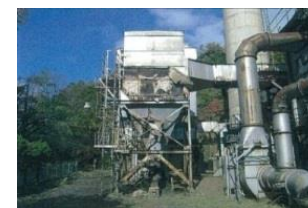
老朽化した廃棄物処理施設の更新
