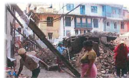
地震による建物の崩壊（地震）
