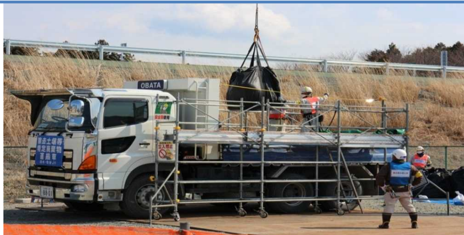
仮置場からの搬出作業
