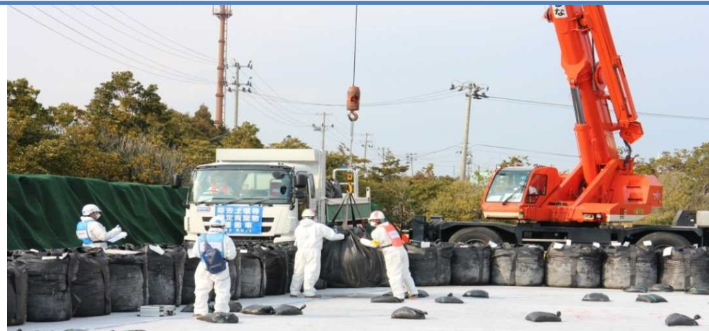
保管場への搬入・定置作業
