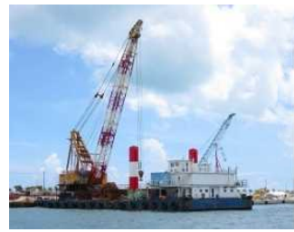
施工クレーン台船
