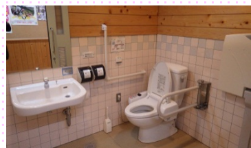
国立公園等における多目的トイレの整備
