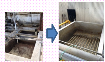
既存の排水処理槽
