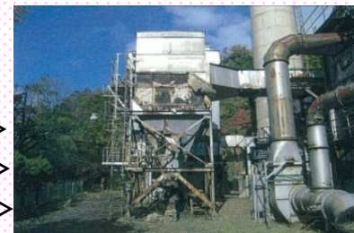
老朽化した廃棄物処理施設の更新
