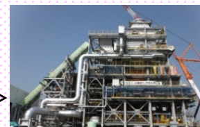
仮設焼却炉の建設状況 (対策地域内廃棄物)
