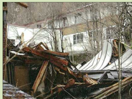
国有地内の廃屋
