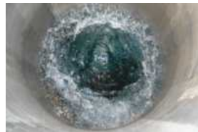
(熊本市) 水道水源井戸
