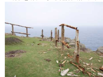
(老朽化した落下防止柵の再整備)
