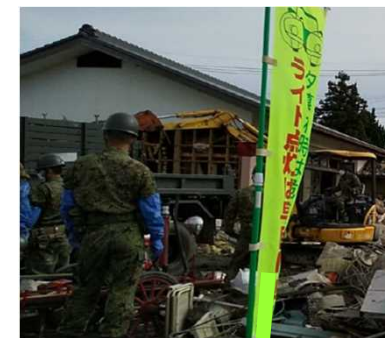
②損壊した家屋等の解体、がれきの収集・運搬及び処分
