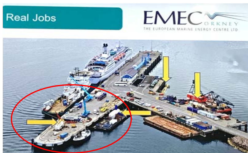
写真 8.5-11 ハットストーン栈橋（赤円が拡張部）
