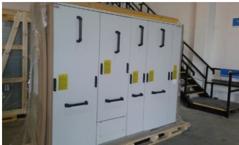
電力変換装置
