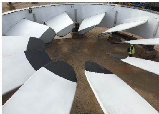
写真 8.5-12 補修中のタービン
