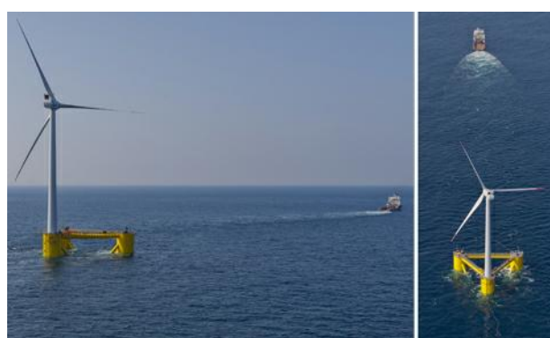
図 1-11 WindFloat プロジェクト
