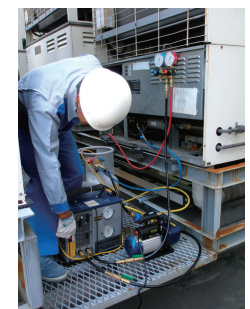
スーパーマーケット冷蔵ショーケース(室外機)からのフロン類冷媒回収の様子
