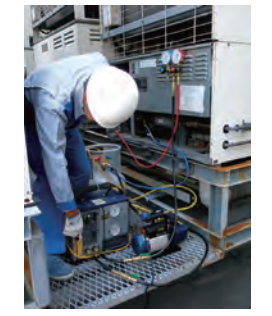
スーパーマーケット冷蔵ショーケース(室外機)からのフロン類冷媒回収の様子 写真提供: 冷媒回収推進・技術センター
